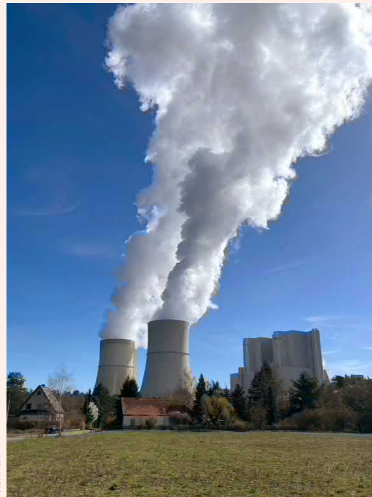
Industriepark Schwarze Pumpe
